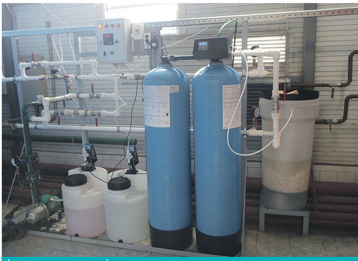
Аккумуляторы химочищенной воды
