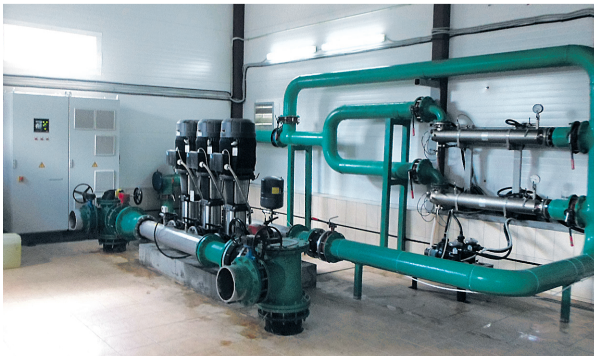
Станция второго подъема (слева) и блок ее управления (справа)
