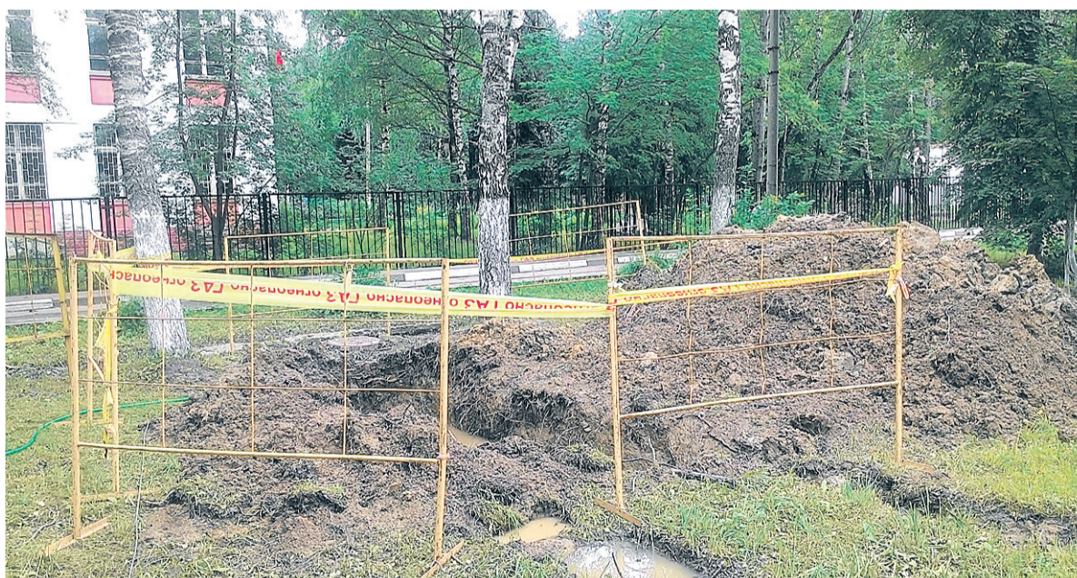
Замена участка водопроводной сети
