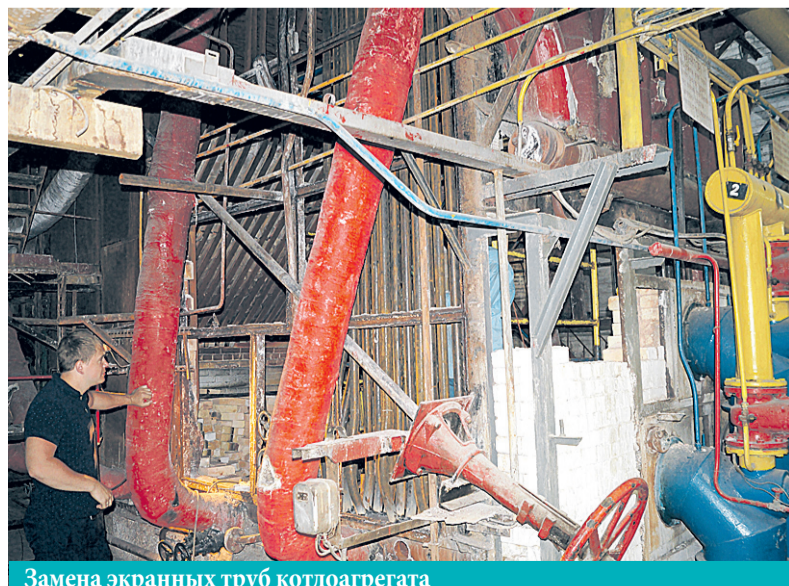
Замена экранных труб котлоагрегата
