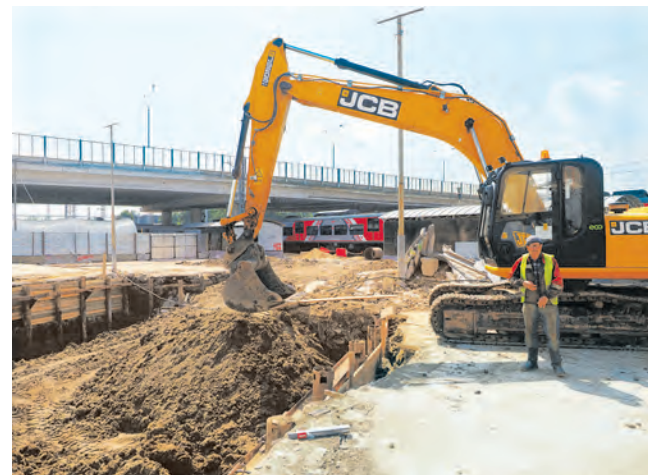
Работы по реконструкции станции Крюково
