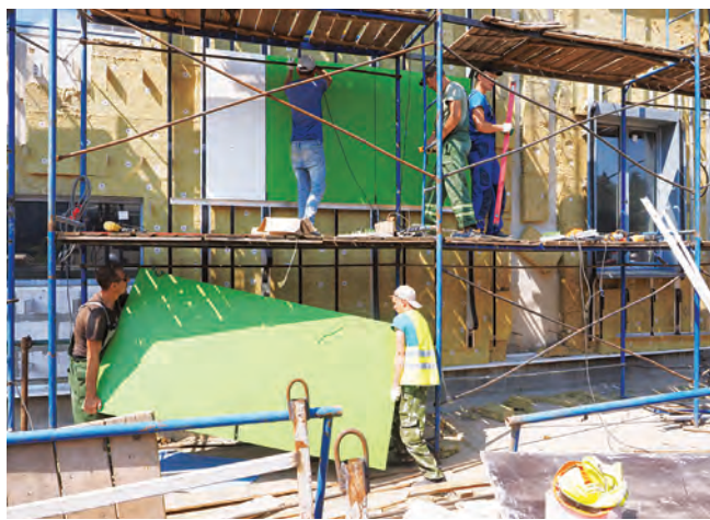
Монтаж фасада ФОКа на площади Колумба
