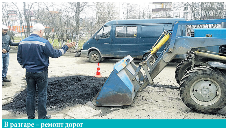
В разгаре – ремонт дорог
