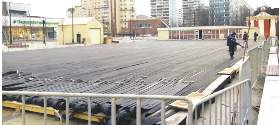
Монтируются катки на площади Юности и в 16-м микрорайоне
