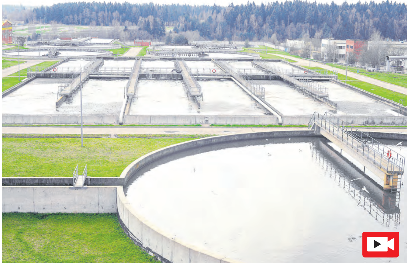
Очистные сооружения на зеленоградском водоканале
