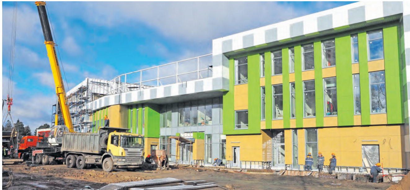
Строительство ФОКа на площади Колумба
