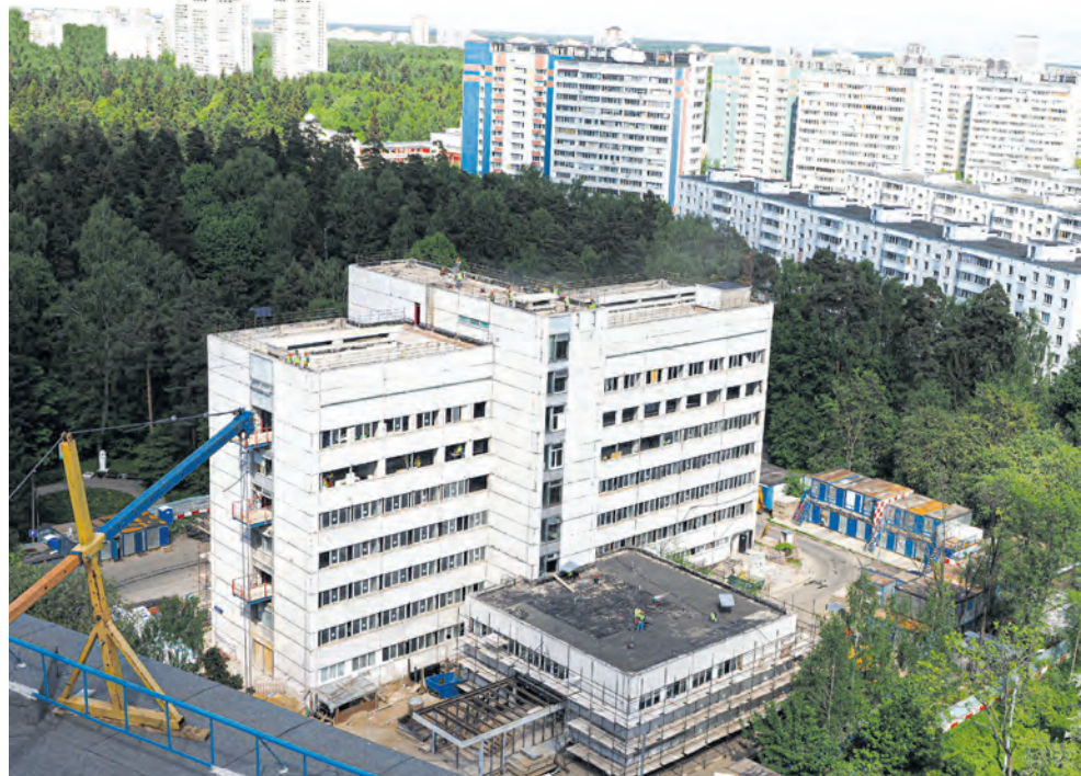
Реконструкция поликлиники в 9-м микрорайоне
