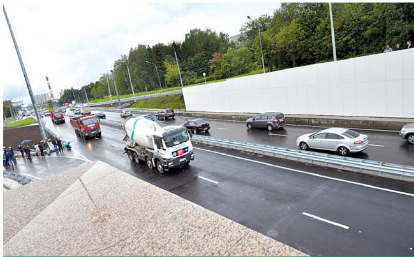
Запущена развязка на 41-м км Ленинградского шоссе
