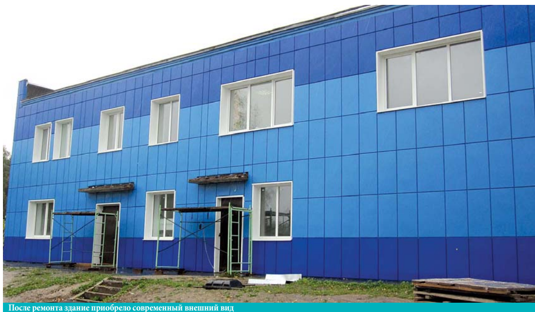
После ремонта здание приобрело современный внешний вид
