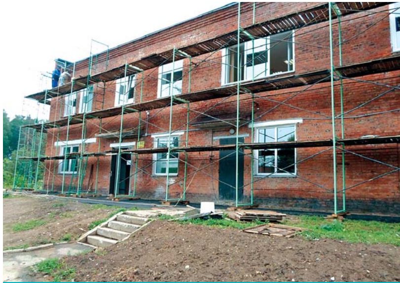
Административное здание ВЗУ до реконструкции
