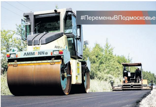
Уже заасфальтировали 17 участков. Сейчас работы по устройству подстилающих и выравнивающих слоев из песка и щебня проводят на подъездной дороге деревни Бухарово. После этого начнется асфальтирование. Протяженность объекта – 2,5 километра. Завершить ремонт здесь планируют до середины октября.
