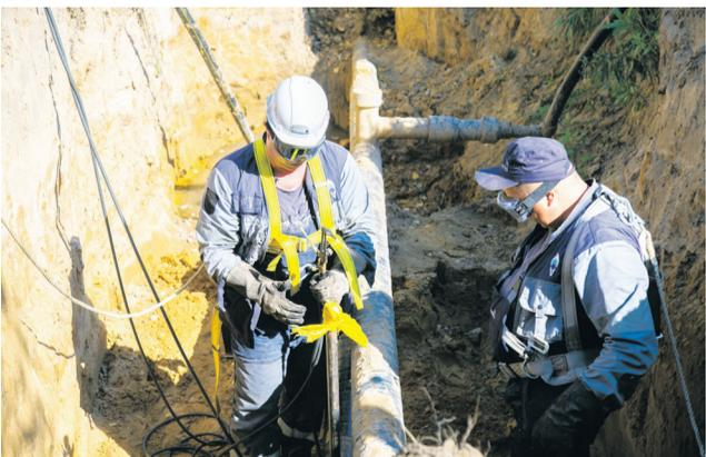
Перед проведением работ специалисты осушили котлован, так как часть газопровода проходит через водоем, убрали байпас и восстановили 100 метров поврежденной трубы.
