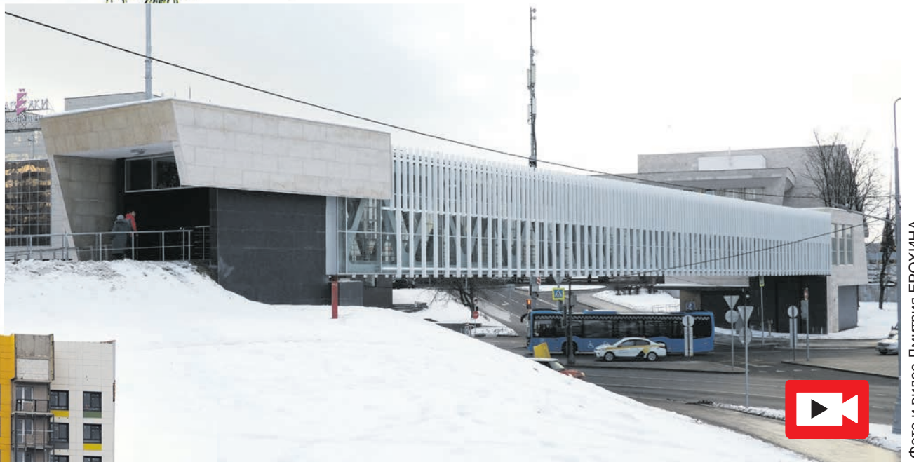
Завершено строительство надземного пешеходного перехода через Савелкинский проезд
