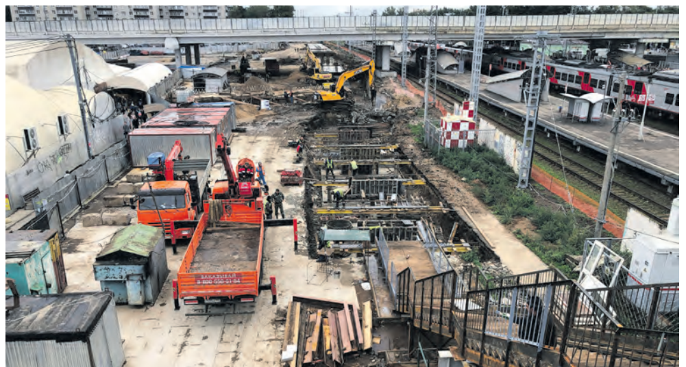
На станции Крюково (Зеленоград) – будущей станции МЦД-3 развернуты масштабные работы
