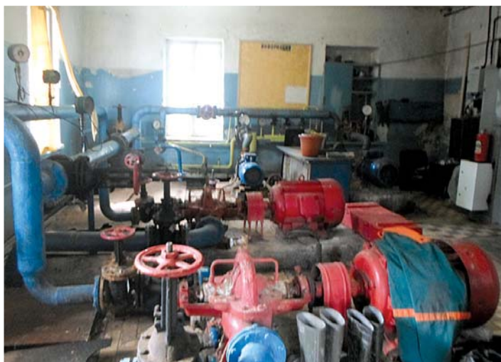
Старая (слева) и новая (справа) станции второго подъема
