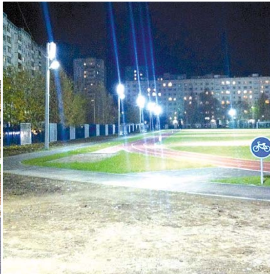
Освещение стадиона «Юность» после реконструкции
