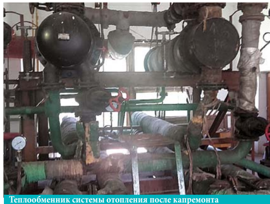
Теплообменник системы отопления после капремонта
