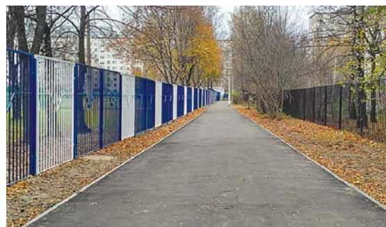
Ремонт тротуара с бордюром на стадионе «Юность»
