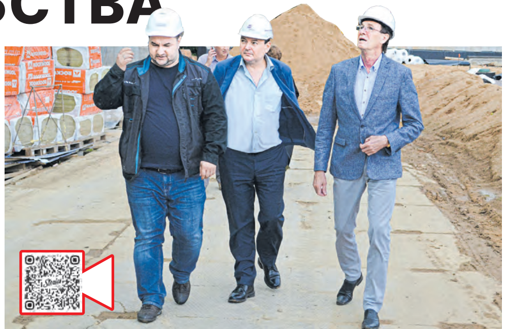
На стройплощадке ФОК на площади Колумба
