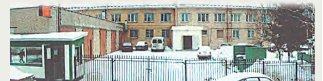
ОВД районов Матушкино и Савелки, с 1963 года – здание Зеленоградского ОВД.
