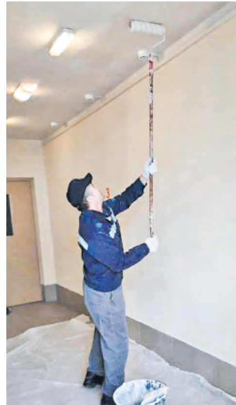
За сезон отремонтировано уже около 100 подъездов
