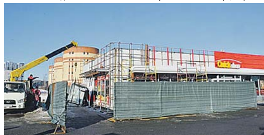
Снос кафе при АЗС на ул. Новокрюковской
