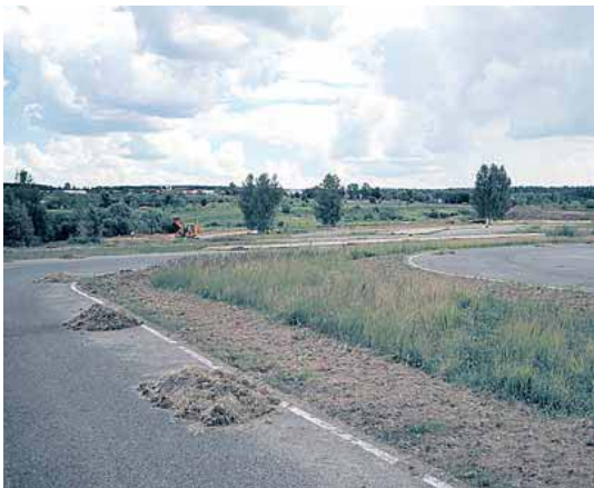
Картодром до ремонта
