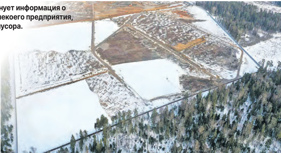
Так сейчас выглядит стройплощадка КПО в Поварово
