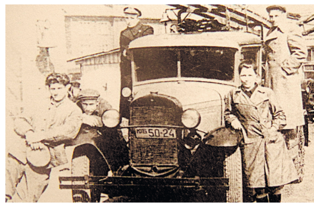
Пожарная охрана завода.
