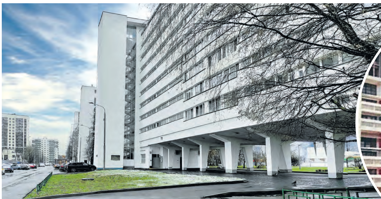
Здание «Флейты». Северный фасад
