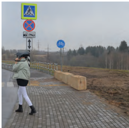
Устанавливаются дополнительные ограждения
