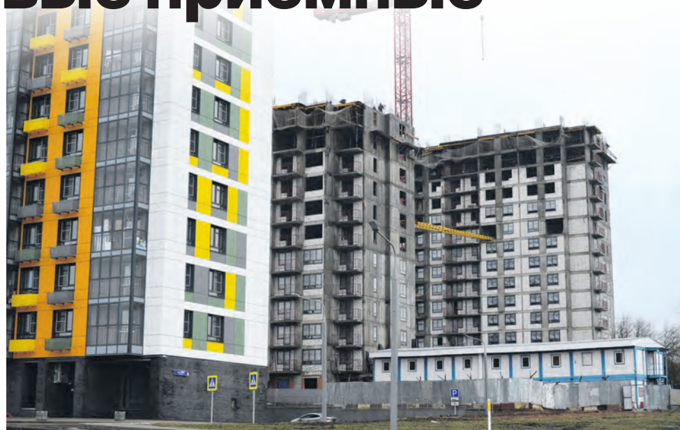
Заканчивается строительство квартала жилых домов в микрорайоне 3Б
