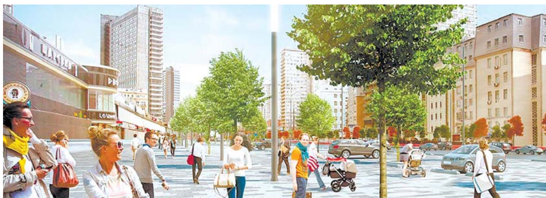
Новый Арбат после реконструкции
