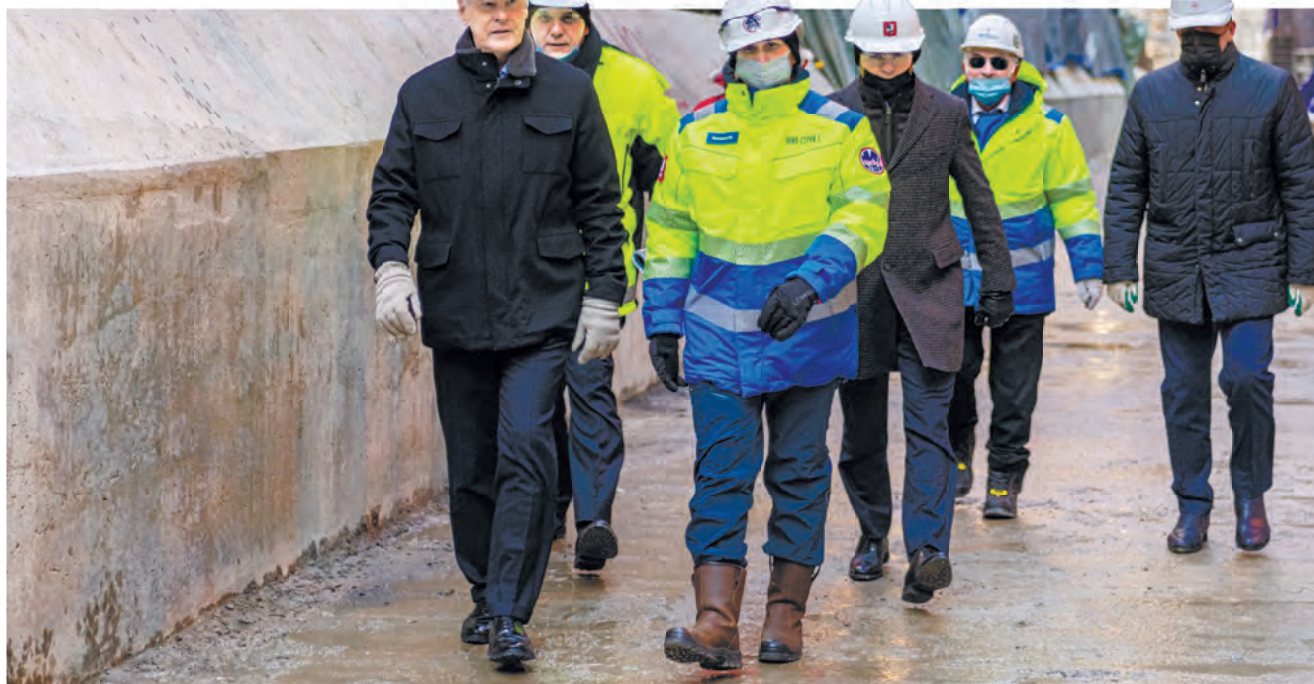
Сергей Собянин дал старт проходке двухпутного перегонного тоннеля от станции «Нагатинский Затон» до станции «Кленовый бульвар» Большой кольцевой линии Московского метрополитена
