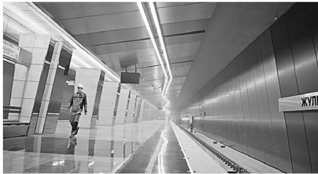
19 сентября 14.18 Будущая конечная станция Таганско-Краснопресненской линии метро «Жулебино»
