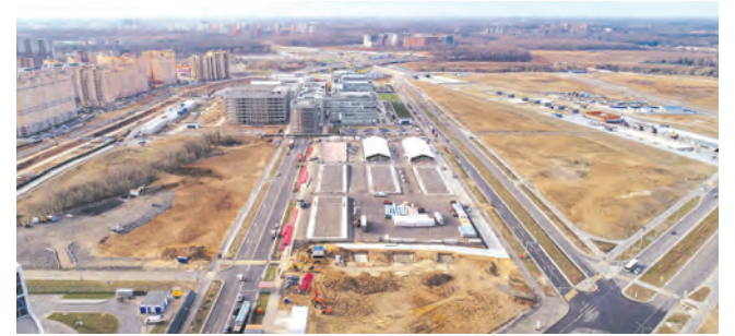
Строительство временных корпусов в Коммунарке
