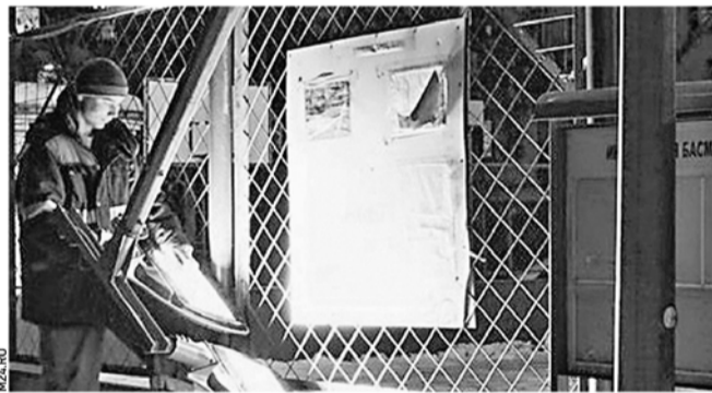
Фонари со складными опорами: замена лампы без вышки
