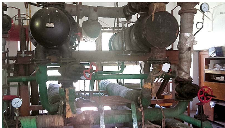
Теплообменник системы отопления после капитального ремонта
