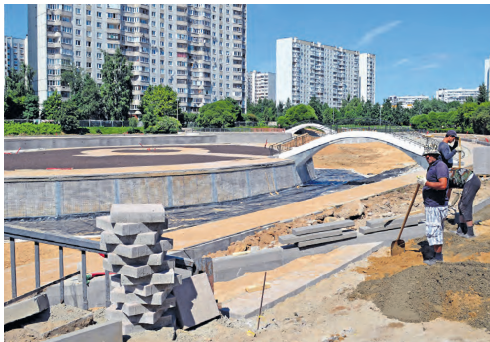
Мосты уже отремонтированы, идет обустройство набережной пруда
