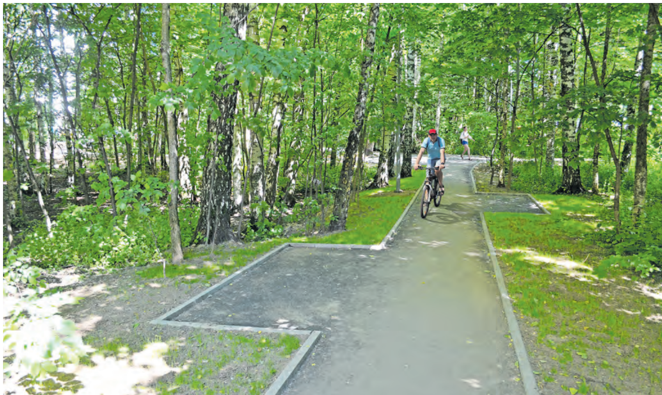
В знаковом объекте «Березовая роща» уже закончена прокладка дорожек
