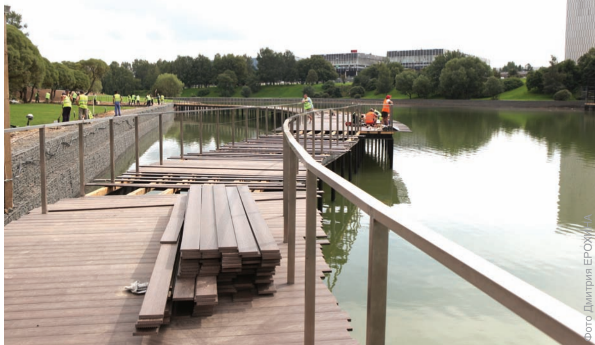
Строятся набережные Большого городского пруда
