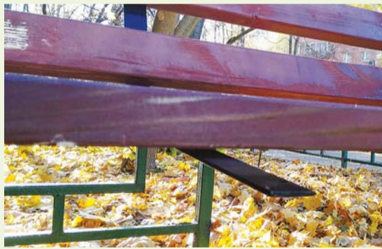
Центральная планка лавки не зафиксирована, крепление к асфальту сделано кое-как.
