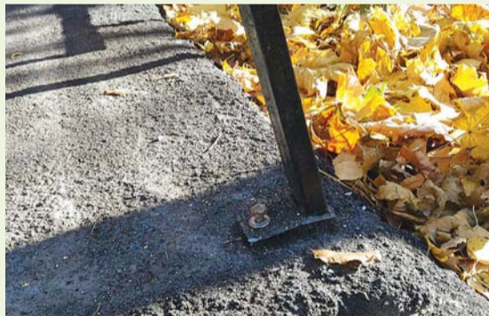
Центральная планка лавки не зафиксирована, крепление к асфальту сделано кое-как.
