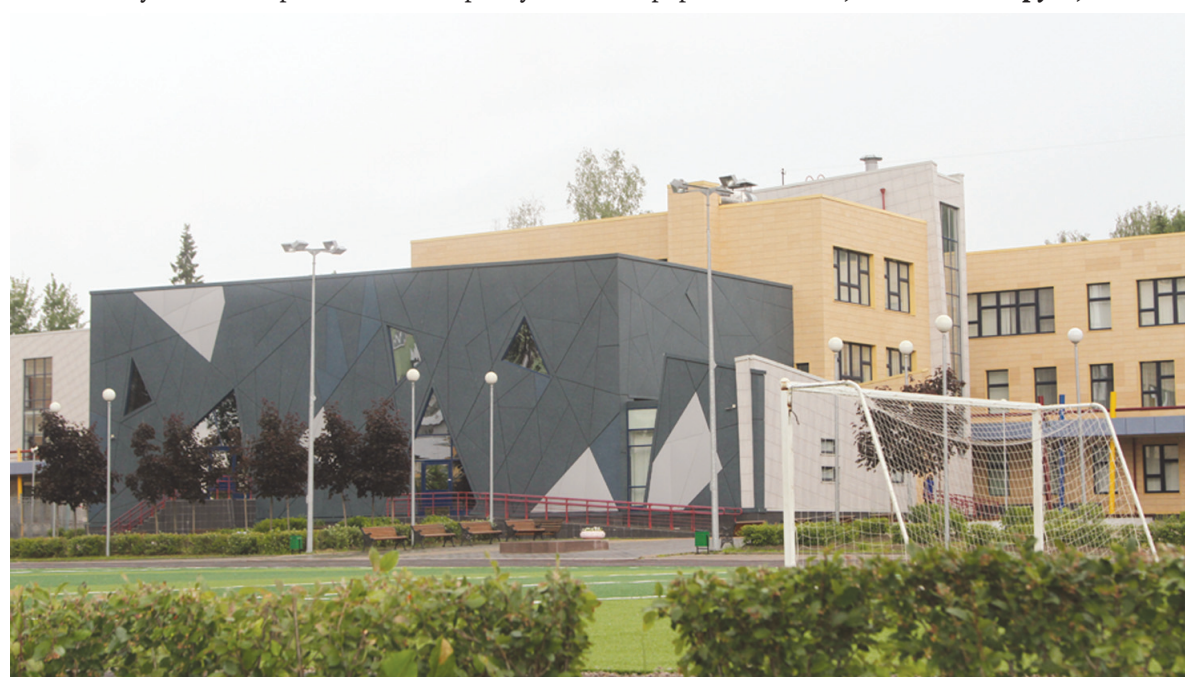
■ В 23-м микрорайоне введена в строй школа на 550 мест, блок начальных классов на 300 мест и детский сад на 280 мест
