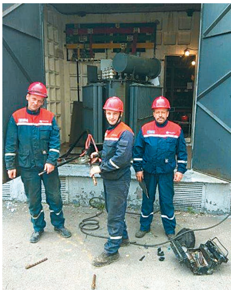
Ремонт концевой муфты в отсеке трансформатора.
