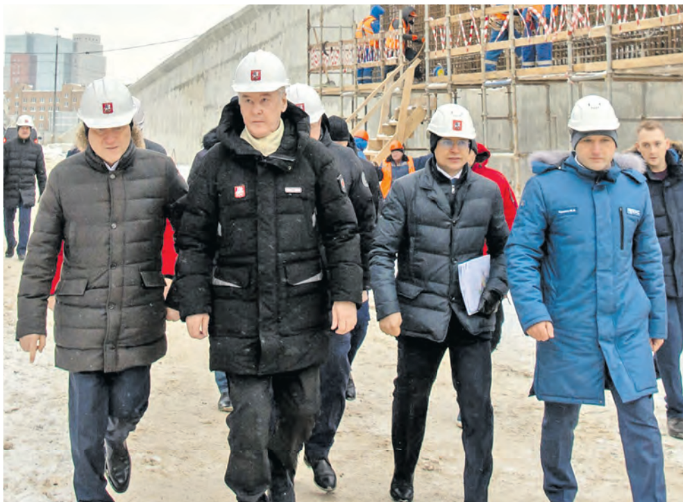
Сергей Собянин: «Строительство крупных магистралей сформирует новый дорожный каркас Москвы».
