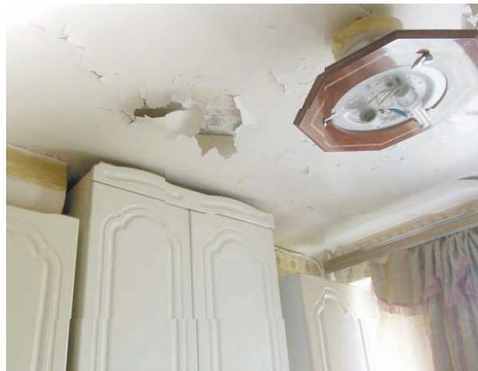
Трубы отопления внутри стен, вентиляция слабая, мало что выветривается. И тесно: холодильник поставили и уже повернуться негде. Обои в кухне не клеить толком не можем и побелить потолок: батареи центрального отопления прямо в стену вмонтированы. Только поклейшь на нее обои – они и отклеиваются.
