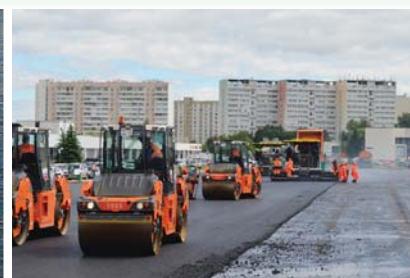
Новое дорожное покрытие на площади перед ДК
