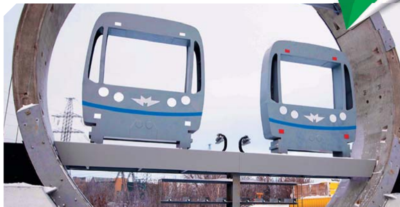
Проходка двухпутного перегонного тоннеля от станции «Косино» в сторону станции «Юго-Восточная»
