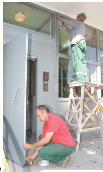
Ремонт подъездов в корпусах
