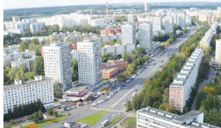
Корпуса вдоль Центрального проспекта будут капитально отремонтированы.
