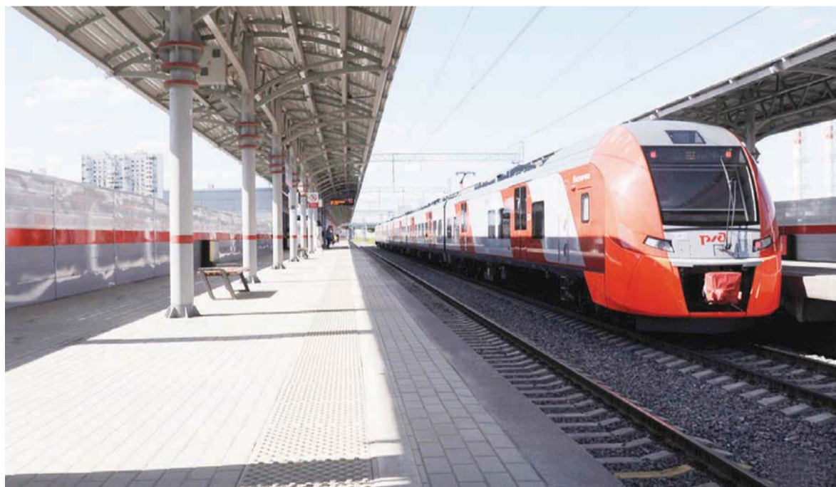
■ Подходы к остановкам, к станциям МЦК, метро, железнодорожным платформам – это особый вопрос.
