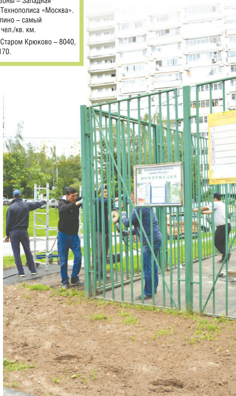
Идет ремонт спортплощадки
