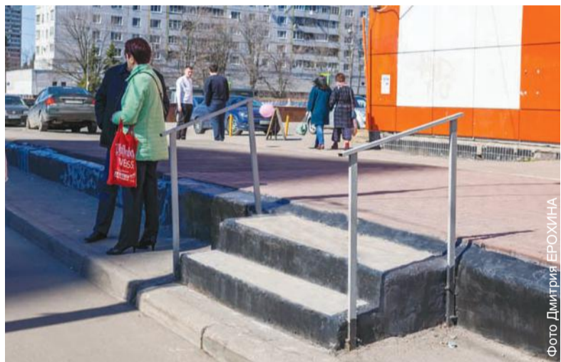
Лестничный марш привели в порядок.
