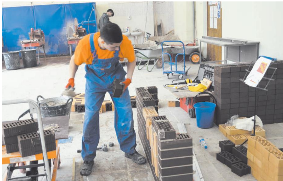
Мастера кирпичной кладки за работой.
