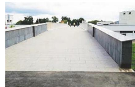
Парапеты моста облицованы полированными серыми гранитными плитами. Также выполнены работы по усилению подпорных стен и замене гидроизоляции
