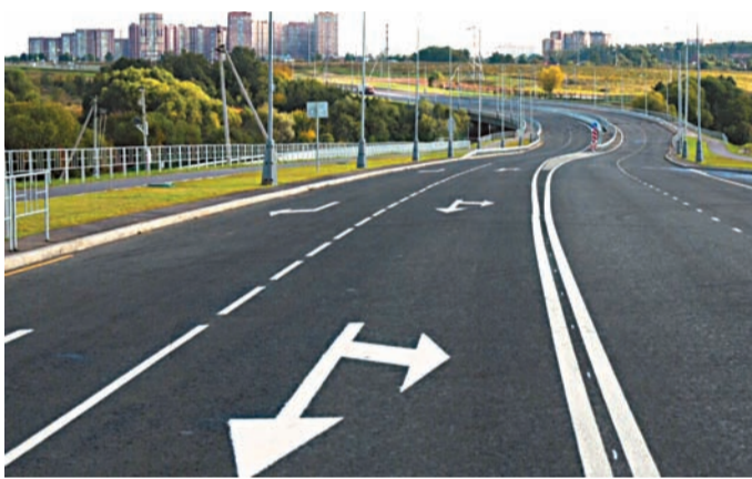
В 2019 году в ТиНАО построено около 35 км новых дорог
