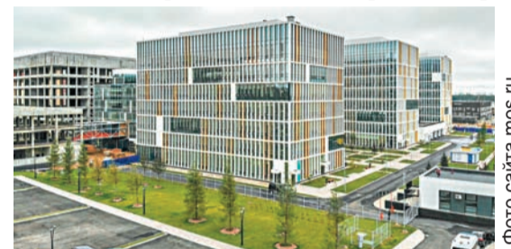
Строительство первой очереди медцентра в Коммунарке планируют завершить в этом году
